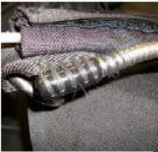
Ehjä putken asennus
