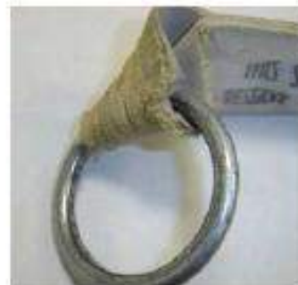
Rispaantunut renkaan kiinnityskohta
